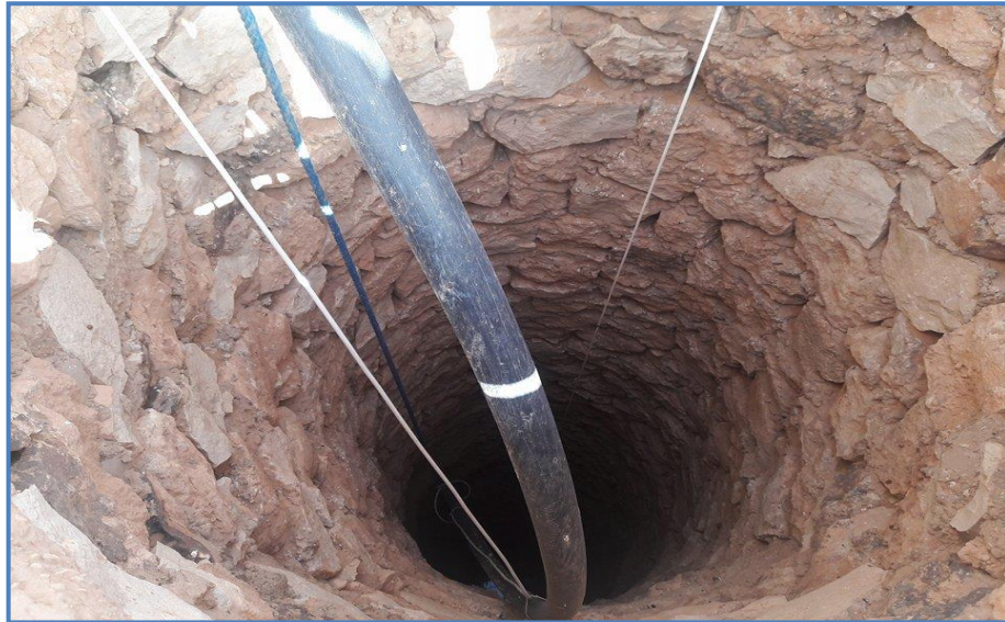
Figure-13 : Vue interne de puits ciblé
