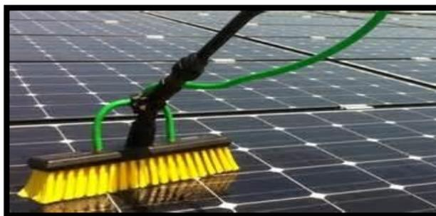
**Figure : II.20 : Nettoyage panneau solaire**
