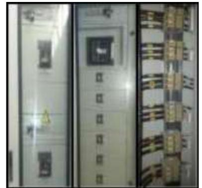
Entre chaque onduleur 250KW et le correspondant enroulement primaire, un interrupteur-sectionneur a été prévu. Les deux sont logés dans le «tableau de liaison», situé dans le bâtiment électrique à côté des onduleurs.
