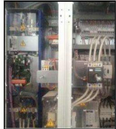
ASI (Ansaldo Sistemi Industriali), type PV8L et PV8M. Ils sont installés dans le bâtiment électrique au milieu du champ. Il y a huit (8) onduleurs, un pour chaque sous-champ :
