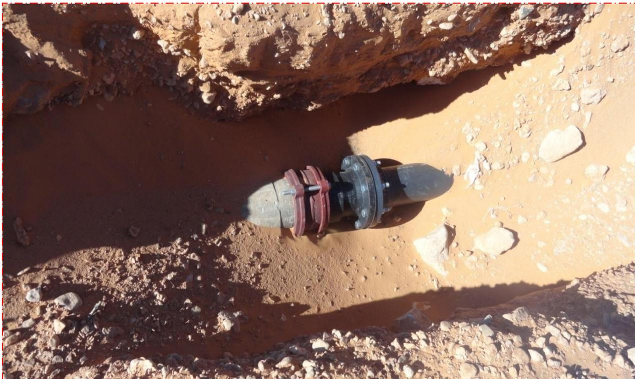
**Figure N°28: Réseau mixte amiante-ciment et PVC**
