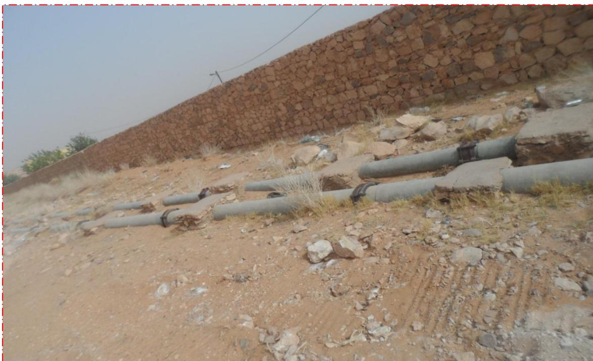
**Figure N°25 - Conduite en Amiante Ciment Apparente**
