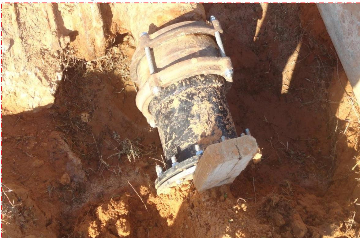
**Figure N°23 - Plaque Pleine et Joint Gibault**
