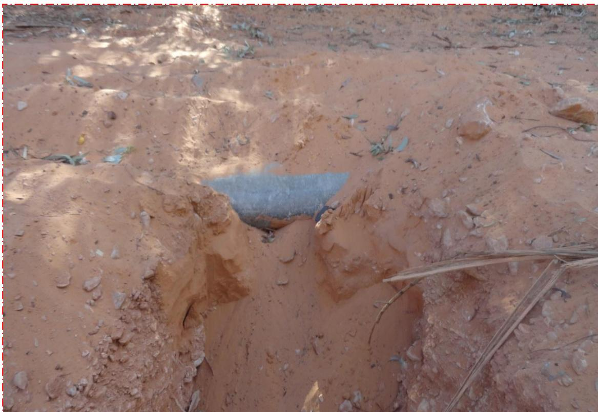
**Figure N°22 - Conduite en Amiante Ciment**
