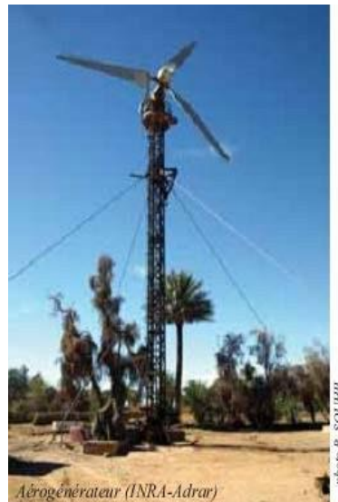
Figure I.33: Photo d'une première éolienne installée en Algérie.
