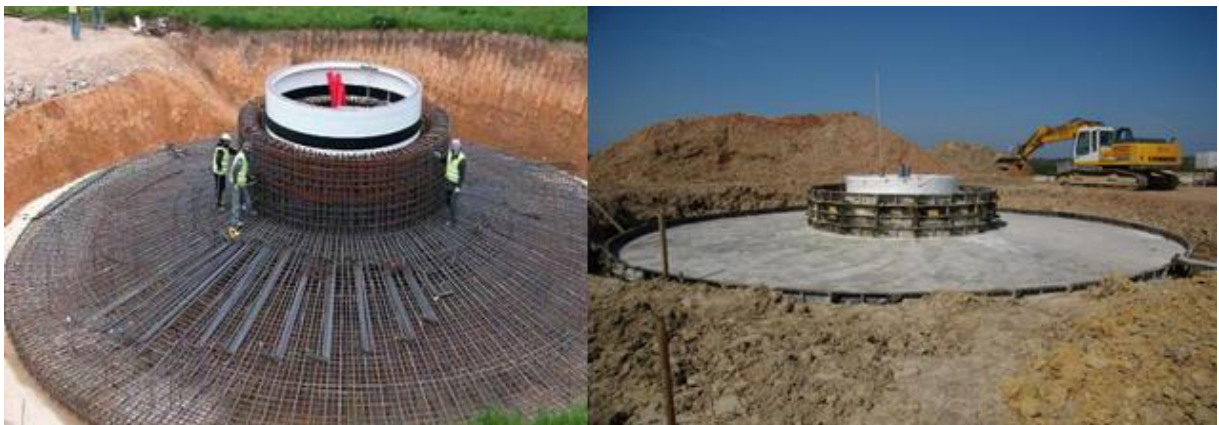
Figure I.24: La fondation en béton.
