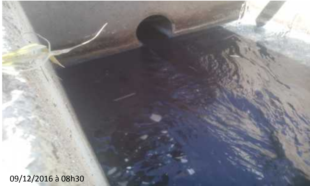
Figure IV-1: Conduite du rejet (où nous avons effectué les mesures)
