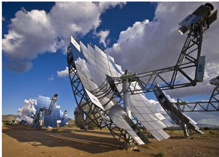
Fig.1.14. Centrale parabolique à moteur *Stirling*. [48]
