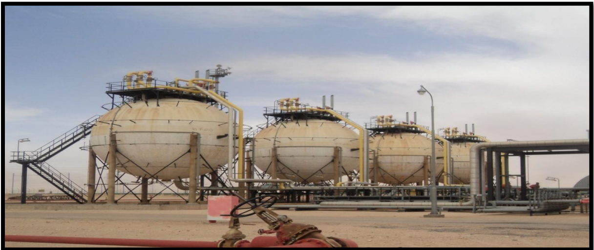
FIGURE II.07 : Schéma de bake de stockage GPL2.
