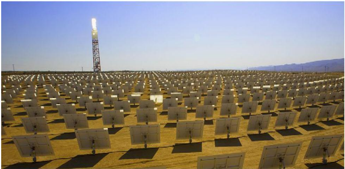
Figure I.14 : Centrale à tour [22].
