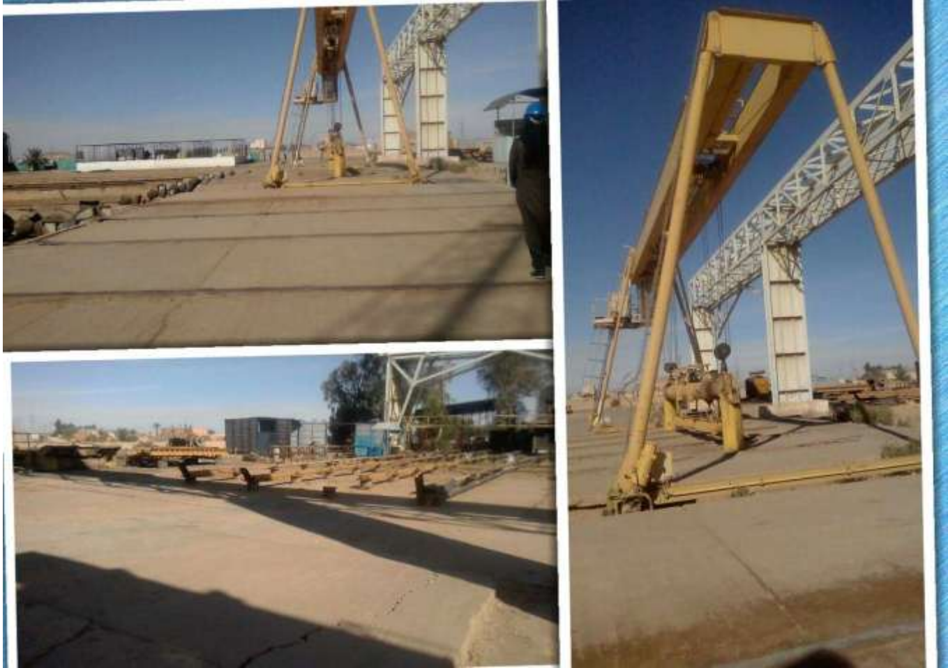
صورة توضح موقع محطة معالجة مياه الصرف الصناعي
