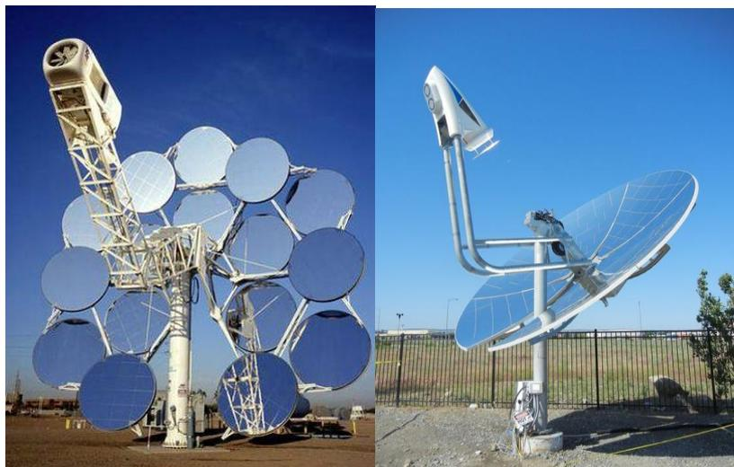
Figure I.15: Concentrateur parabolique.
