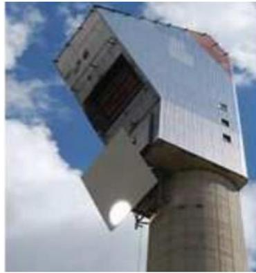
**Figure I.12 :** Le récepteur d'une centrale solaire à tour. [28]
