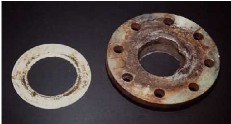
Figure I.III : Corrosion caverneuse d'un acier allié sous un joint. [07]
