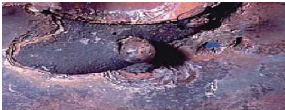
Figure I.II : corrosion galvanique au niveau d'une zone de brasage entre la brasure Cu-p et le tube en cuivre. [07]
