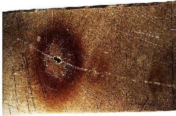
Figure I.IV : Corrosion par piqûres sur la paroi d'une cuve en acier inoxydable austénitique Cr18-Ni10. [07]
