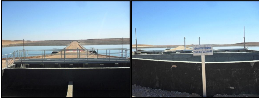
Photo 03 : répartiteurs principales vers les bassins primaires et secondaires.
