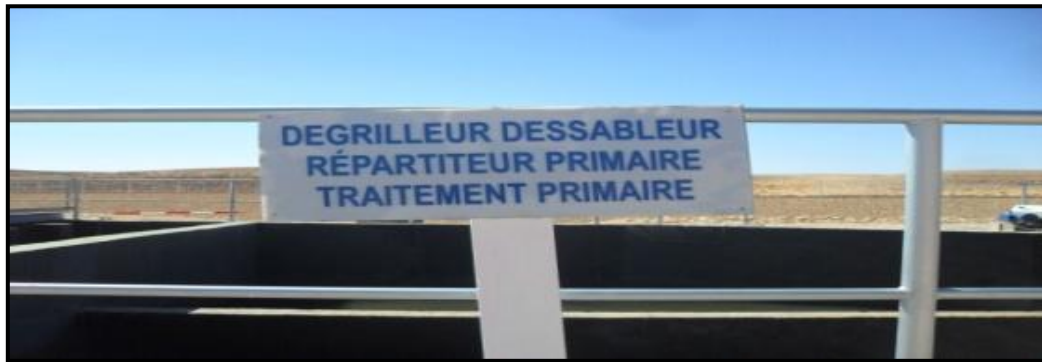
Photo 02 : Dégriateur et dessableur (STEP, 2021).
