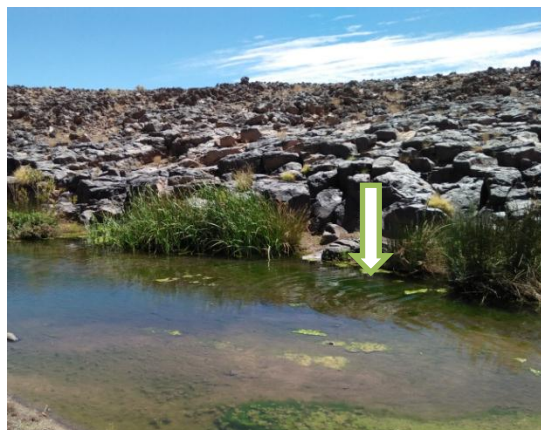
Photo 03 : Station d'épuration des eaux usées « STEP » El Atteuf Ghardaïa (Original).
