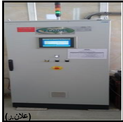
الصورة43 : جهاز تحكم آلة الحرق
