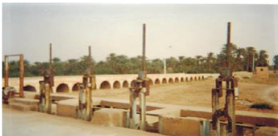
Figure 9 : Barrage de dérivation à Guerrara (DJILI. 2004).
