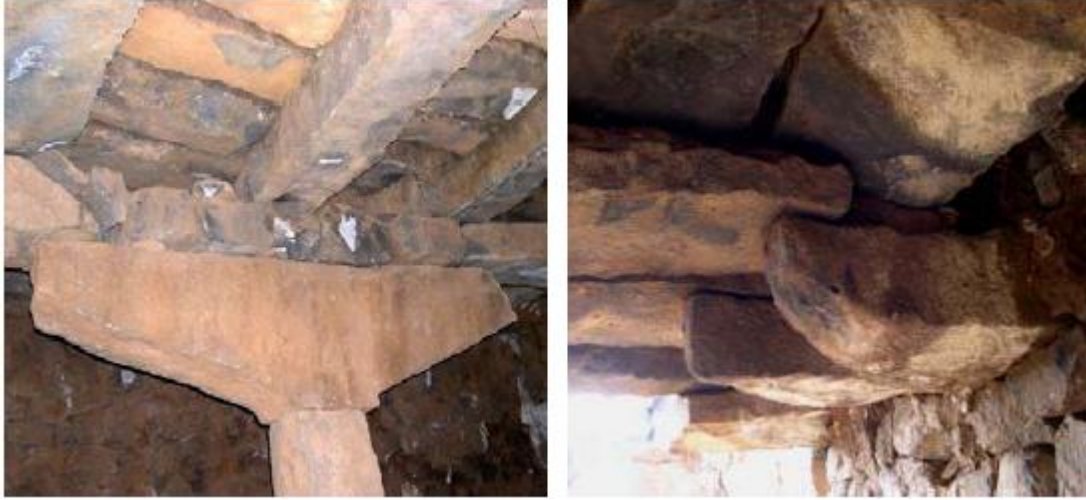
الصورة 23: تبين الصورة نماذج للتسقيف بالحجر
