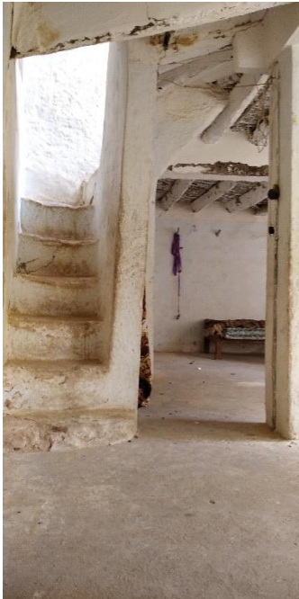
الصورة 12: توضح الصورة الدرج المؤدية للسطح
