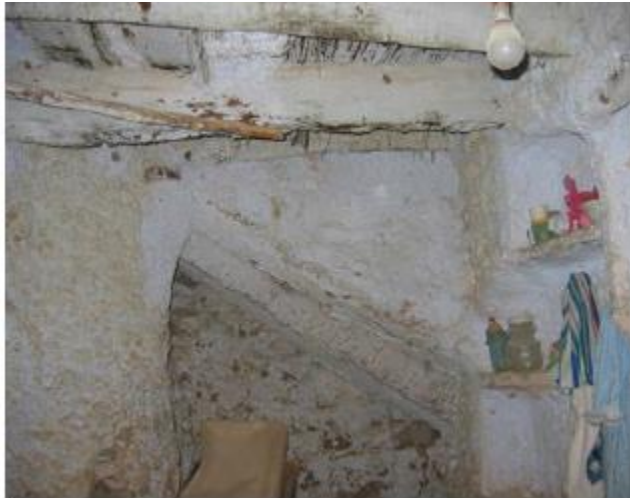
سقف درج محمول فوق جذوع النخل
