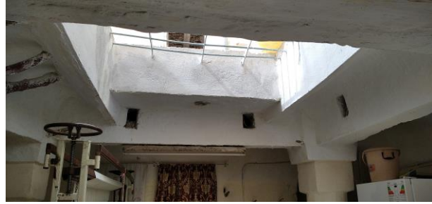
الصورة 8: صورة من الطابق الأرضي تبين فتحة التهوية والأعمدة
