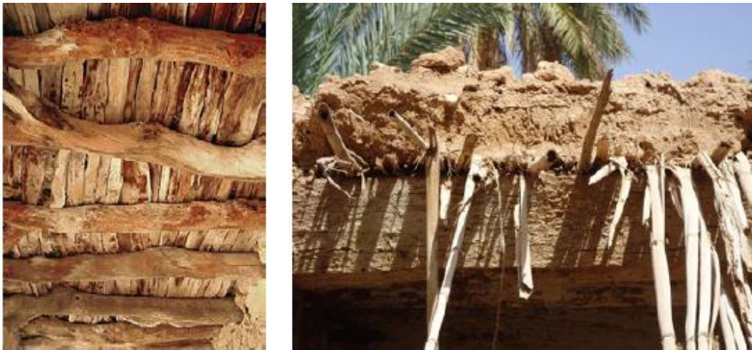
الصورة 24: تبين الصورة نماذج للتسقيف الخشبي
