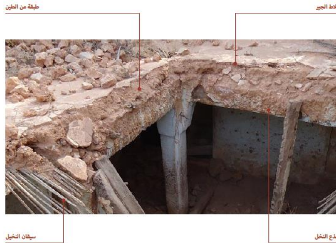
الصورة 28: تبين الصورة التسقيف المسطح بجذوع النخل
