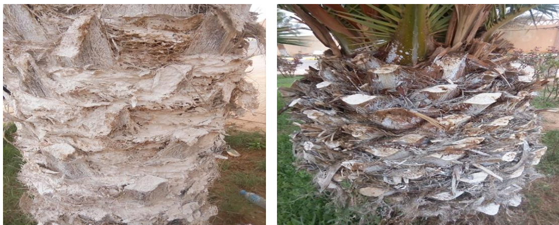
Photographie N°15: la chaux sur le tronc de palmier dattier ( ORIGINALE )
