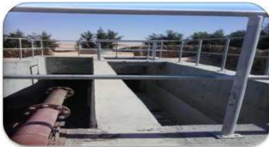
Photo 14: Canal de transport des eaux usées. (à gauche)
