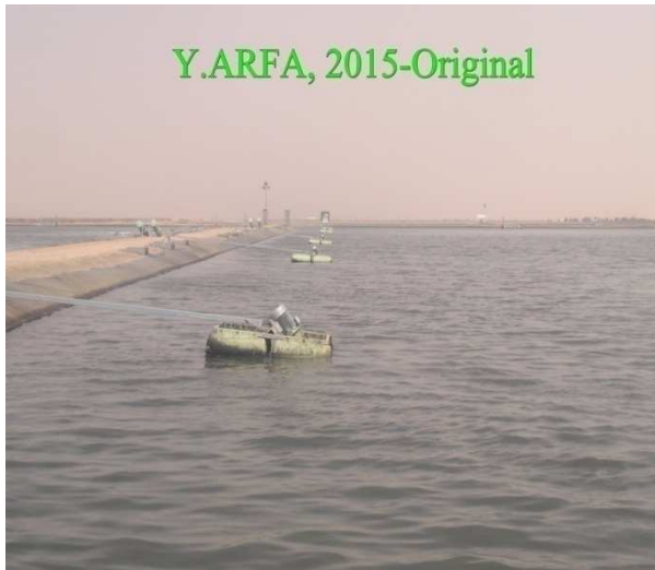
Photo12 : Lagune d'aération. «Original»
