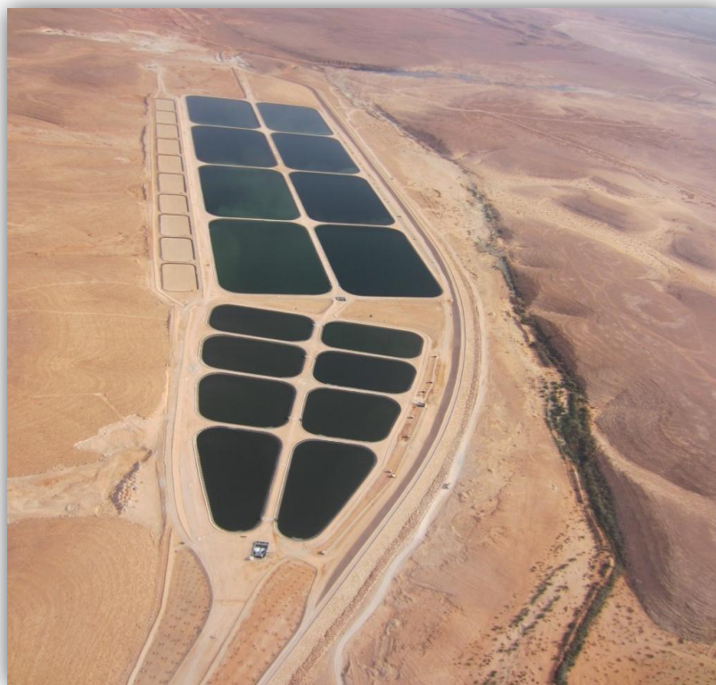
Photo 3.1. Station d'épuration de Ghardaïa (DREW, 2014)
