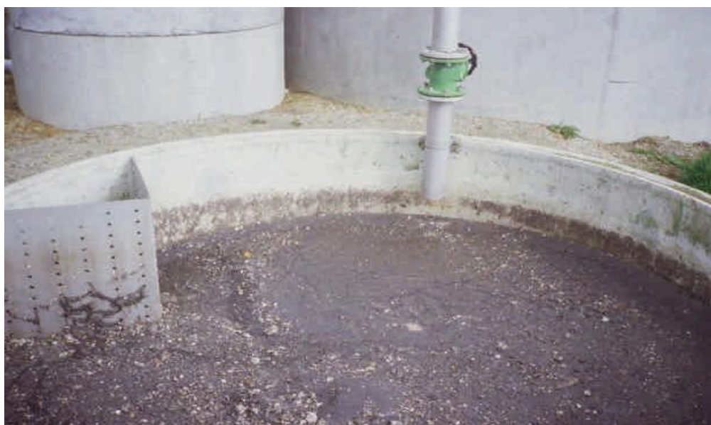
Photo 2.2. Extraction du sable d'un dessableur-dégraisseur (Pronost et al. 2002)
