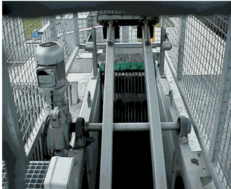
Photo 2.1. Grille mécanique courbe (Djabelkhir, 2007)
