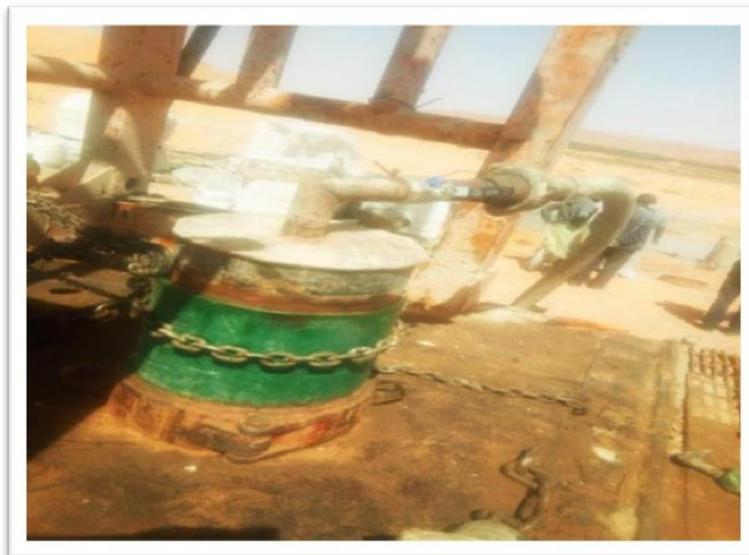
Figure. N°19 : l'injection du ciment.
