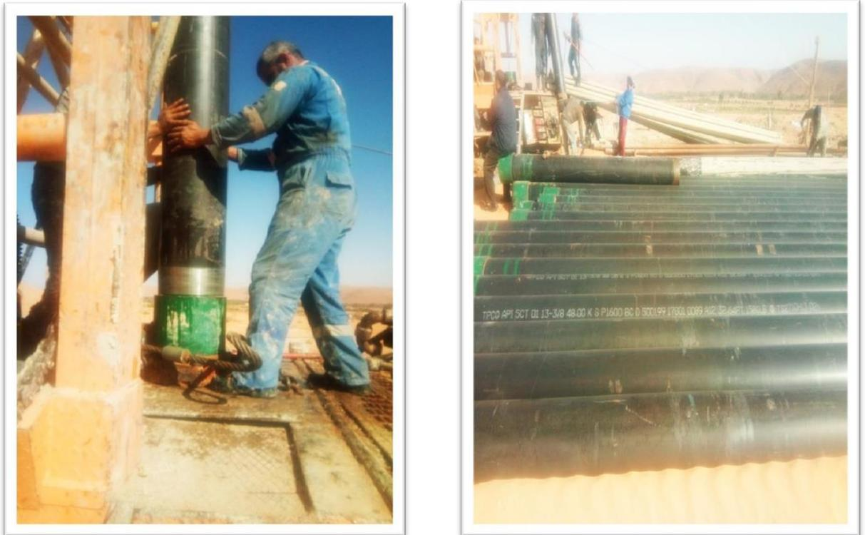
Figure. N°13 : Mise en place du tubage API 13 3/8"
