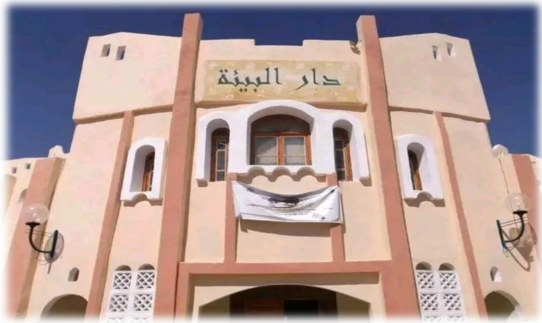
Figure 10: Maison de l'environnement de wilaya Ghardaïa (MEG ,2014)
