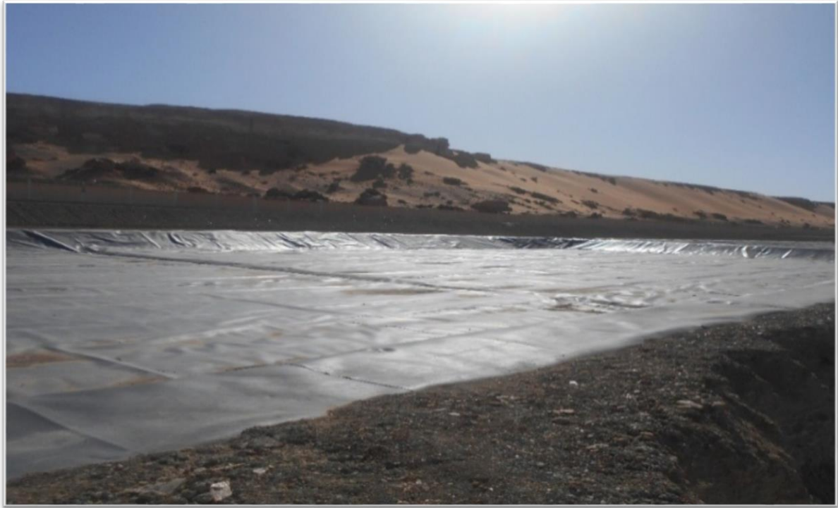
Figure 8.IV: Lit de séchage (Incomplet)
