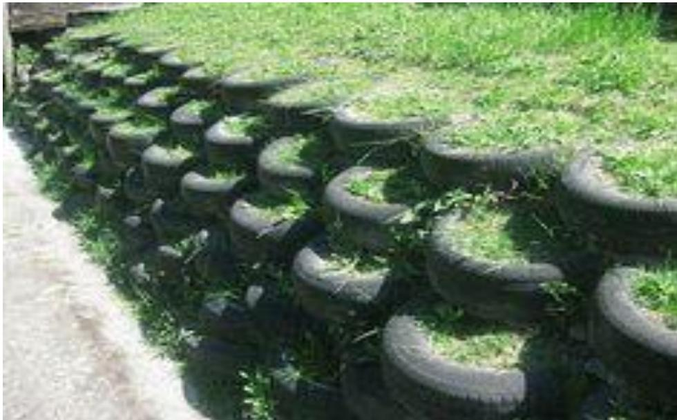
**Figure 39** utilisation les pneu usagé pour protéger les berges du bassin d'infiltration
