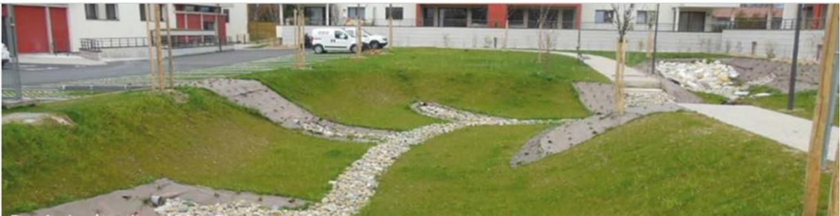
Figure 9 Noues d'infiltration
