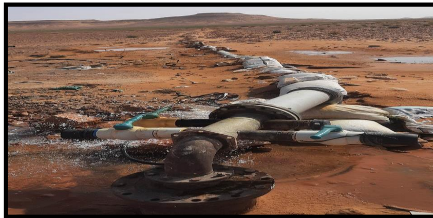
Figure 24 : la pente entre le fourrage et l'unité centrale.
