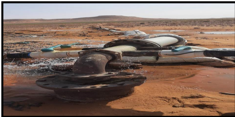
Figure 22 : Raccordement entre la conduite et le forage
