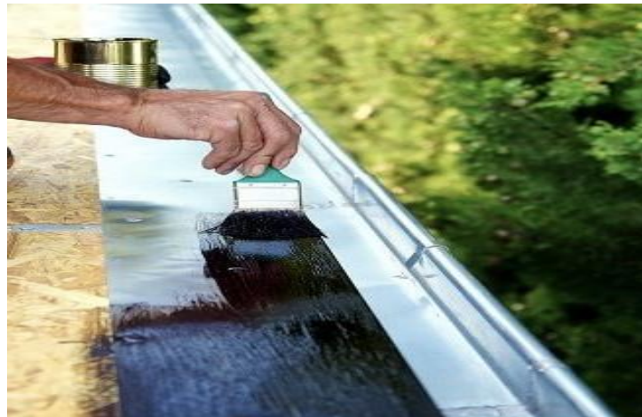
Figure III.1: Travailleur appliquant un BMP en revêtement imperméable à un toit[28]
