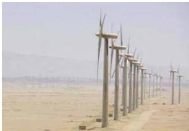
Figure 1-15 : La ferme éolienne de Kabertène (wilaya d'Adrar) [22].
