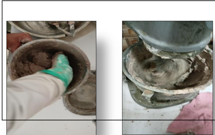
Photo. II.21. Le malaxage des mortiers (LTPS)
