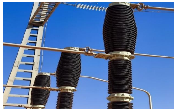
Figure II.10 : Disjoncteur à gaz SF6
