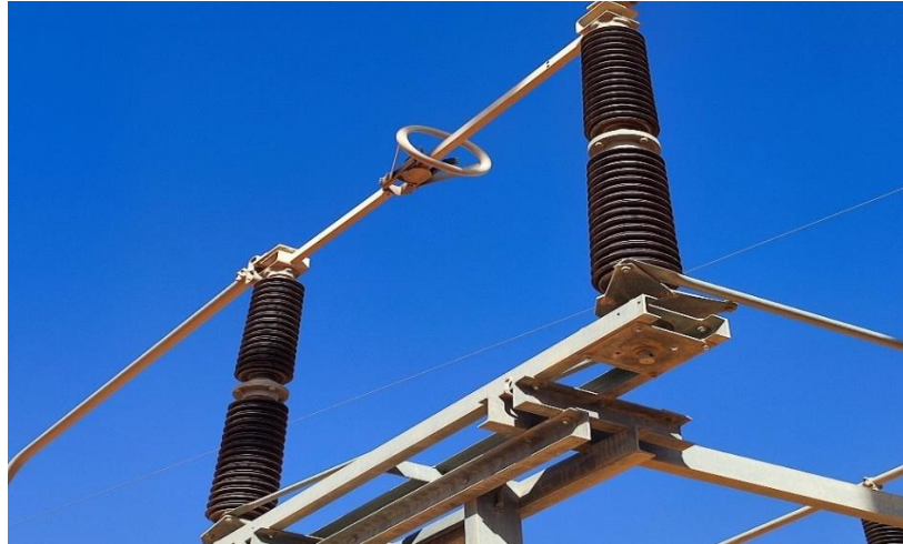
Figure II.12 : sectionneur HTB
