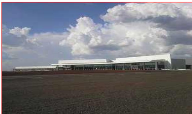
Figure I.4. Le nouvel aéroport« Brisbane West Wellcamp » en Australie réalisé avec un béton géopolymère. [43]
