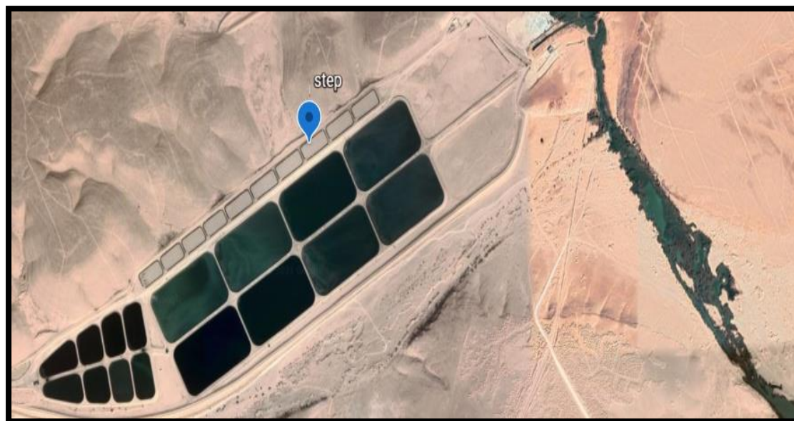
Figure 17 : Vue aérienne de la STEP d'El Atteuf 2021
