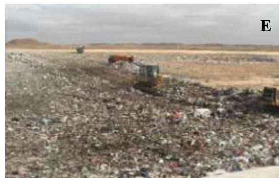
Figure 08. Déchargement de la quantité des déchets (le tri manuellement) et le terrassement par un Bull (C).
