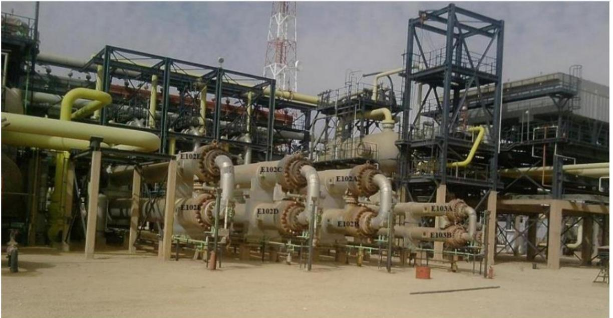
Figure III- 5: échangeur de chaleur E102 A/F [photo réelle]
