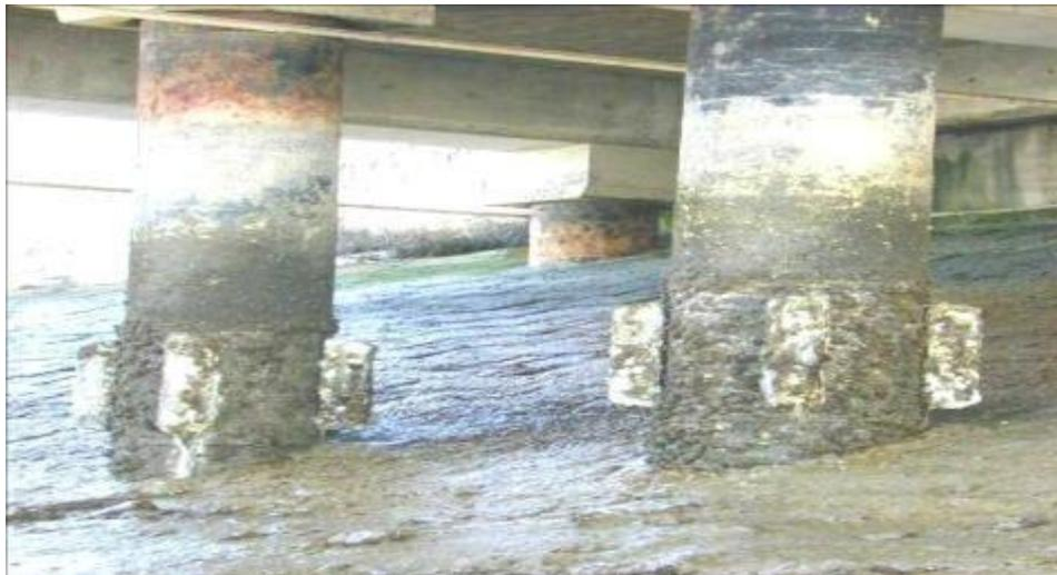
**Figure II-1** : Cas pathologiques d'éléments en béton en contact avec des sulfates [30]
