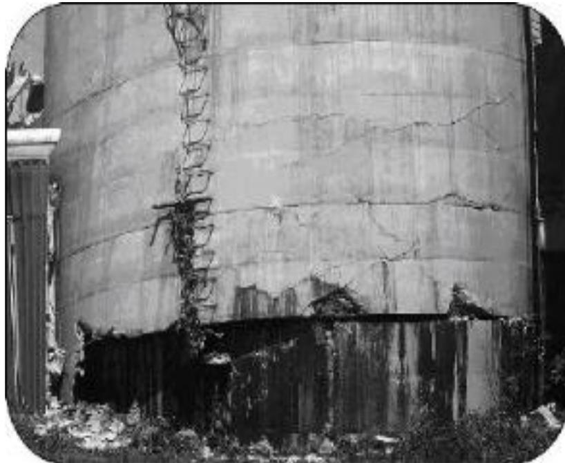
**Figure II-4** : Attaque par les acides [43].
