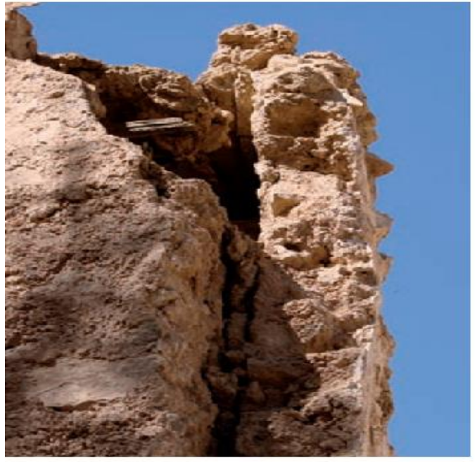
صورة ( 12 ) : بعض أضرار التشققات والانتفاخات. [12]
