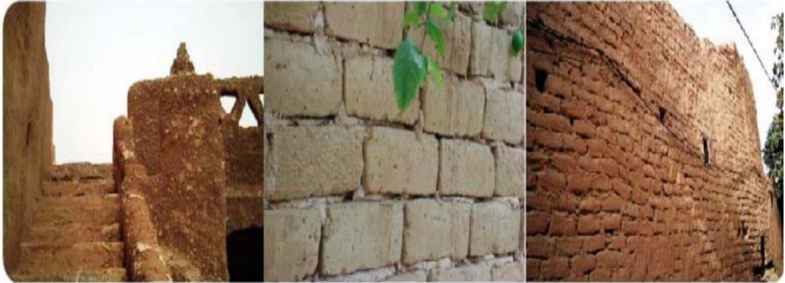
صورة (6): صورة لبناء تقليدي بواسطة الطين. [6]
