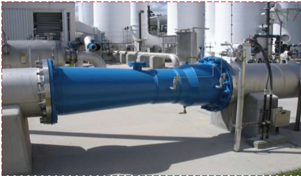
Figure (I-18) : Tube de Venturi dans l'industrie pétrolière [16]
