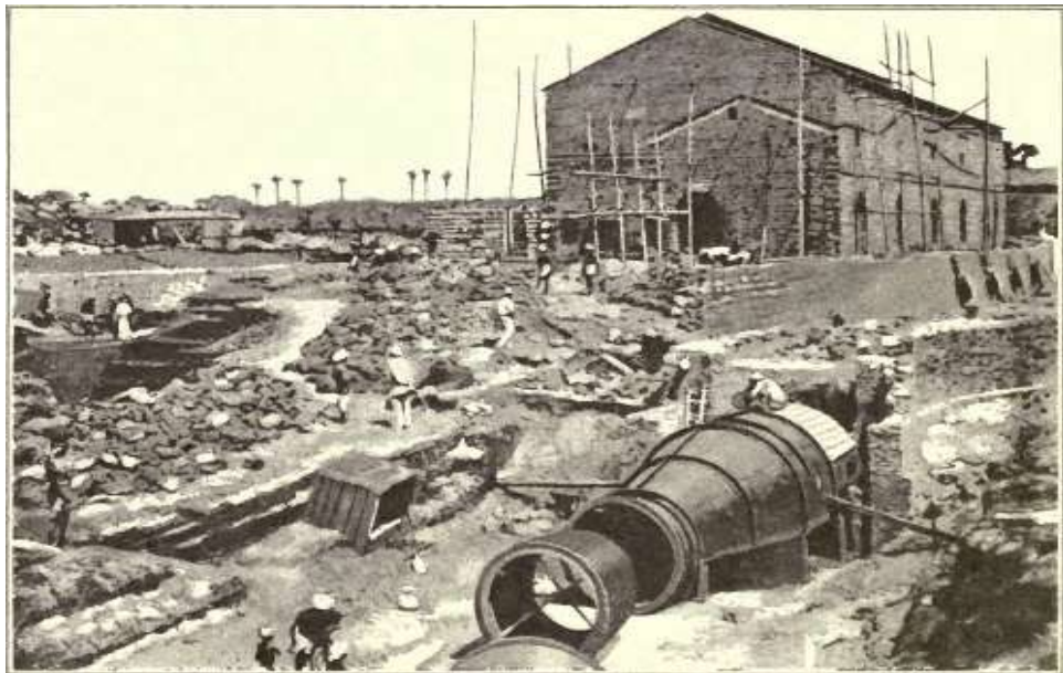
Figure (I-16) : Installation d'un gros tube de Venturi permettant de mesurer 14 000 000 gallons par heure, adduction d'eau à New York [14]
