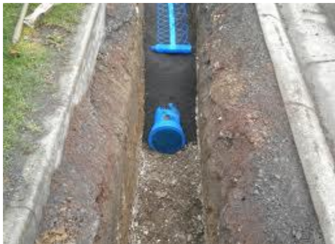
Figure N°27 - Remblai des tranchées
