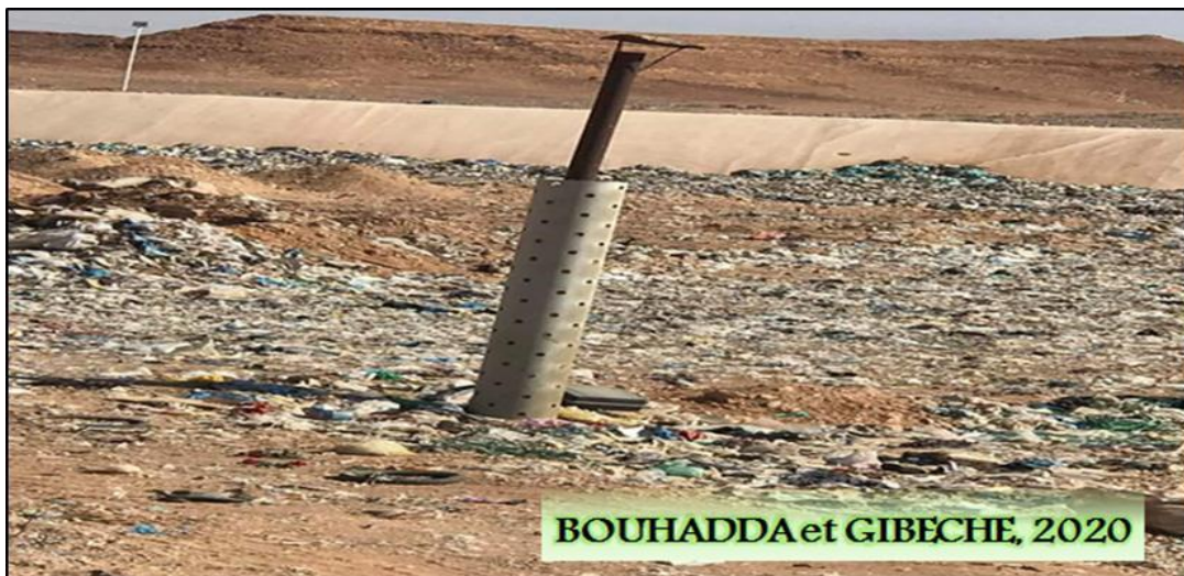
Figure 25 : Système de récupération du biogaz
