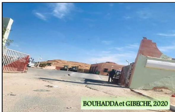
a: Portail de l'entrée (principal)
