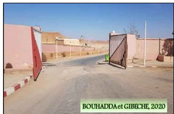
b: Portail de centre de tri et la décharge
