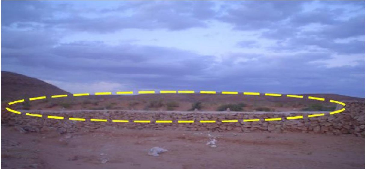
Photo III-3 : Déversoir de canal de Bouchémdjene vers le canal de Bouchène
