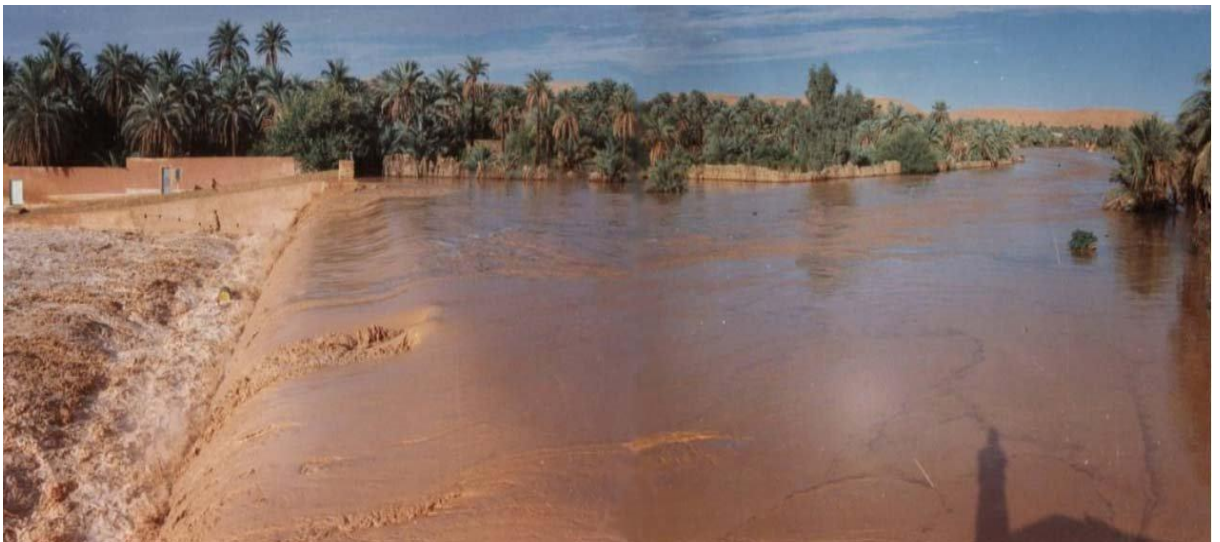
Photo III-14 : Digue de « Ahbas Ajdid »
