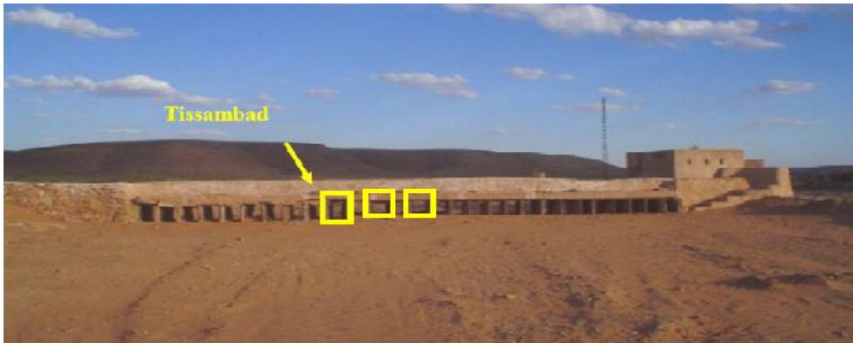
Photo III-1 : Ouvertures de régularisation de canal de Bouchemdjene
