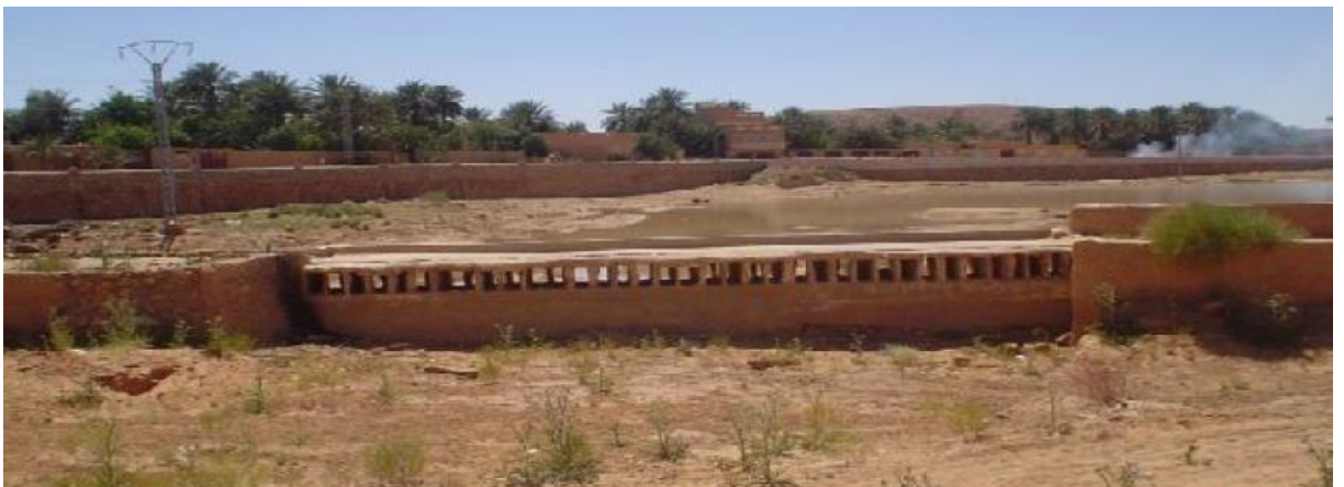
Photo III-4 : Déversoir de canal de Bouchemdjene vers le barrage de Bouchène
