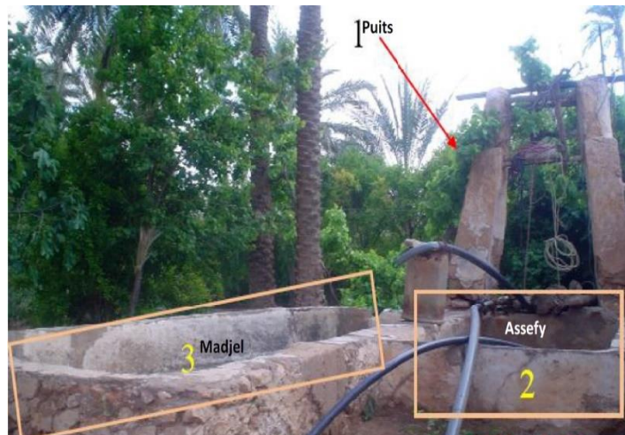
Photo III-15 : Système de puisage
