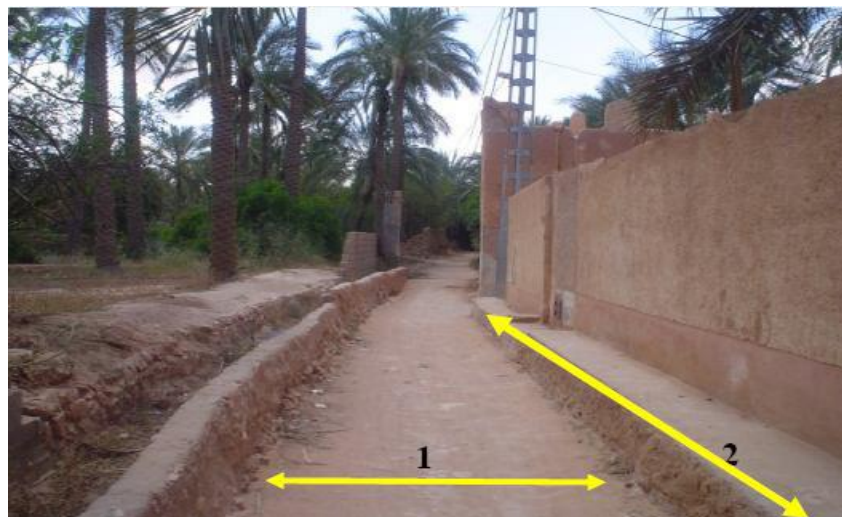
Photo III-11 : Canal à ciel ouvert
