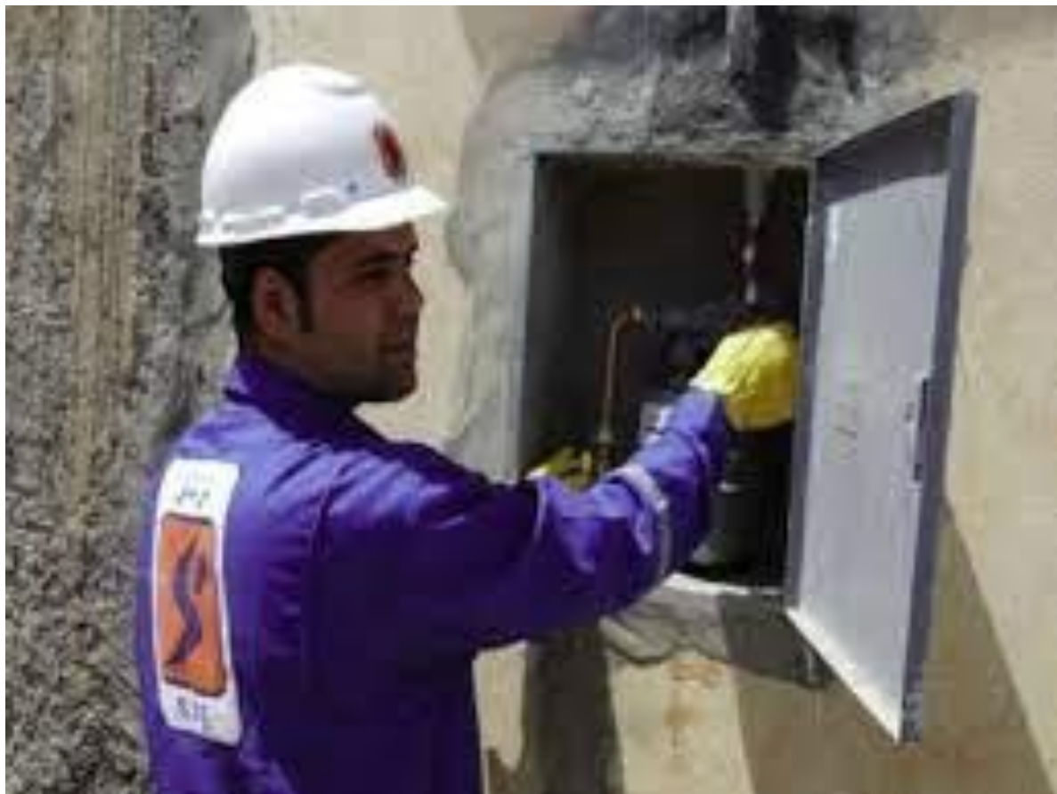
الصورة 2 تعين الشبكات الداخلية للمنازل
