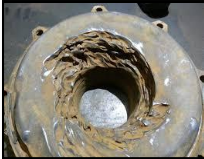
Figure I.6 : Corrosion-érosion d'un ensemble de régulation de pompe à eau
