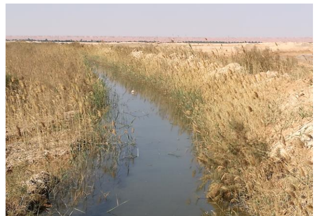
Photo N°08 : Etat des drains
