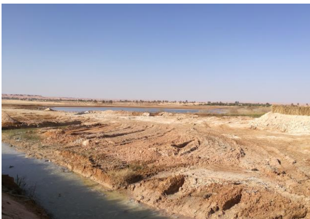
Photo N07: Stagnation des eaux dans les points bas.
