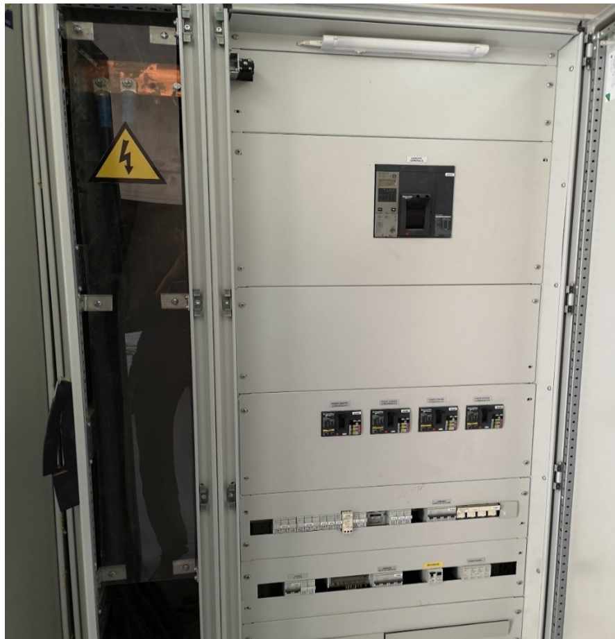
Figure 3-1 : Tableau Electrique
